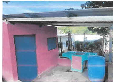
Foto 4: Puerta y ventana de metal, techo y estructura.
