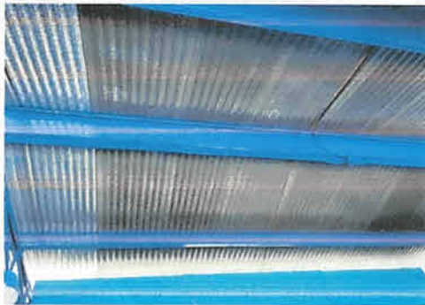
Foto 5: Estructura del techo de la escuela pintada.
