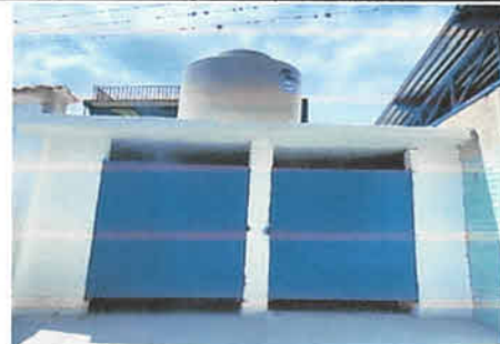
Foto 6: Módulo de 2 sanitarios nuevos, con terraza y deposito de agua.
