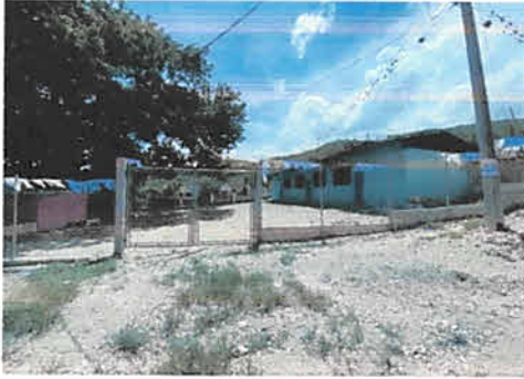
Foto 1: Ingreso a la escuela, porton de malla y tubo galvanizado con candado.
